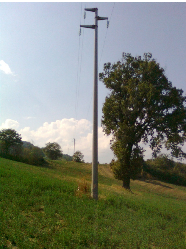
Vista attuale del palo nr.9 – Tronco 2 , da sostituire con palo in acciaio.
