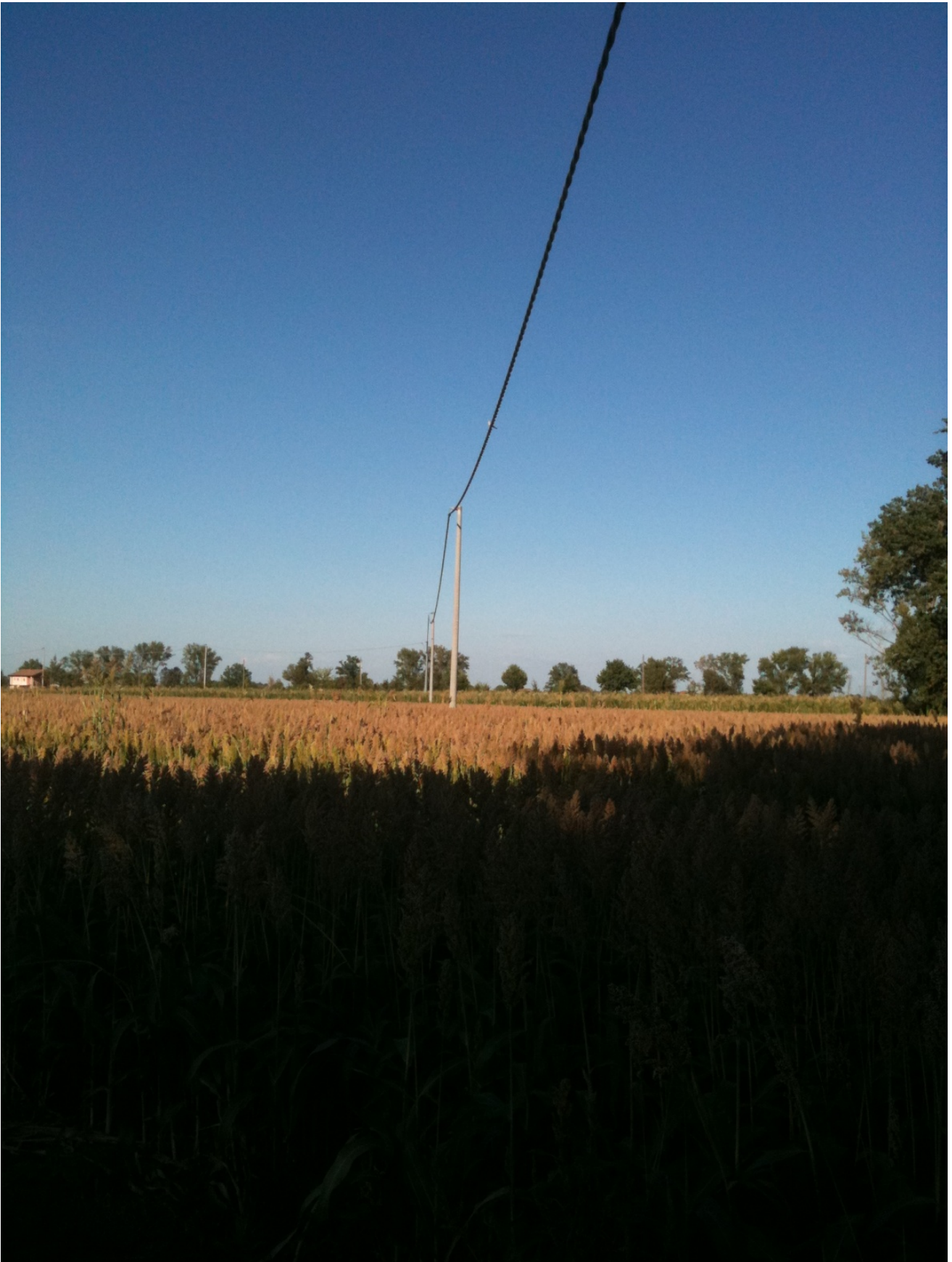
Esempio di foto panoramica post-operam, con i soli conduttori sostituiti (rimasti i pali in cemento esistenti) .
