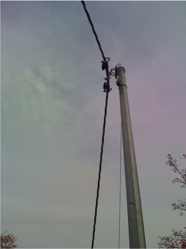
Esempio di fase costruttiva di installazione di elicord su palo in acciaio (come quello da infiggere in sostituzione al palo in cemento nr.5 tronco 3).
