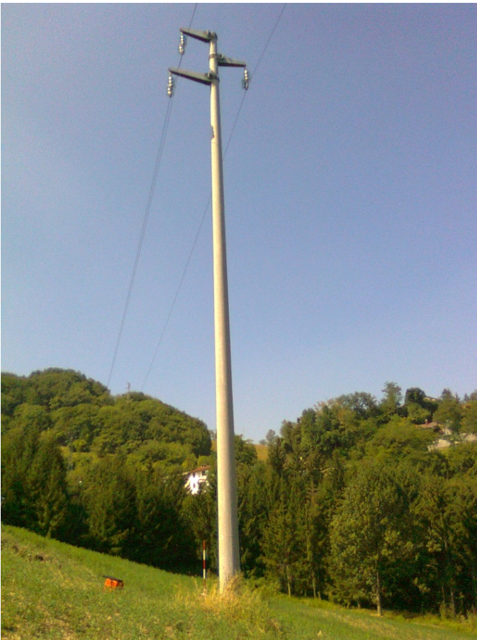
Vista attuale del palo nr.31 - Tronco 2, da sostituire con palo in acciaio.
