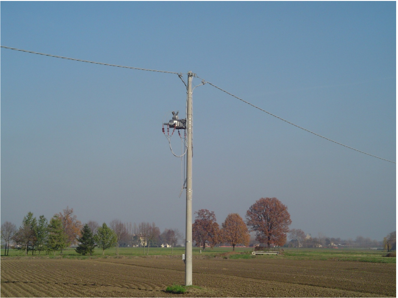
Altro esempio di foto post-operam con i soli conduttori sostituiti (rimasti i pali in cemento esistenti) .
