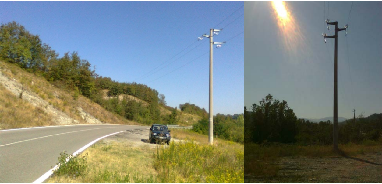
Nr. 2 viste del palo esistente in cemento armato compresso – picchetto nr. 5 Tronco 3.
