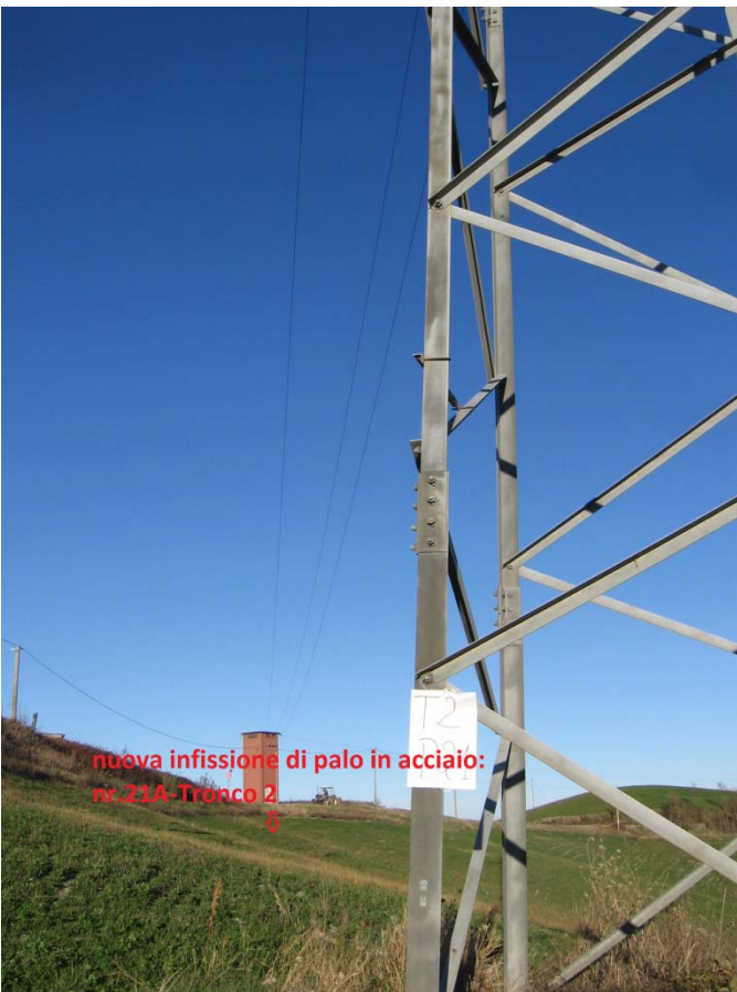
Vista attuale del posizionamento del nuovo palo in acciaio da infiggere: nr.21A – Tronco 2.
