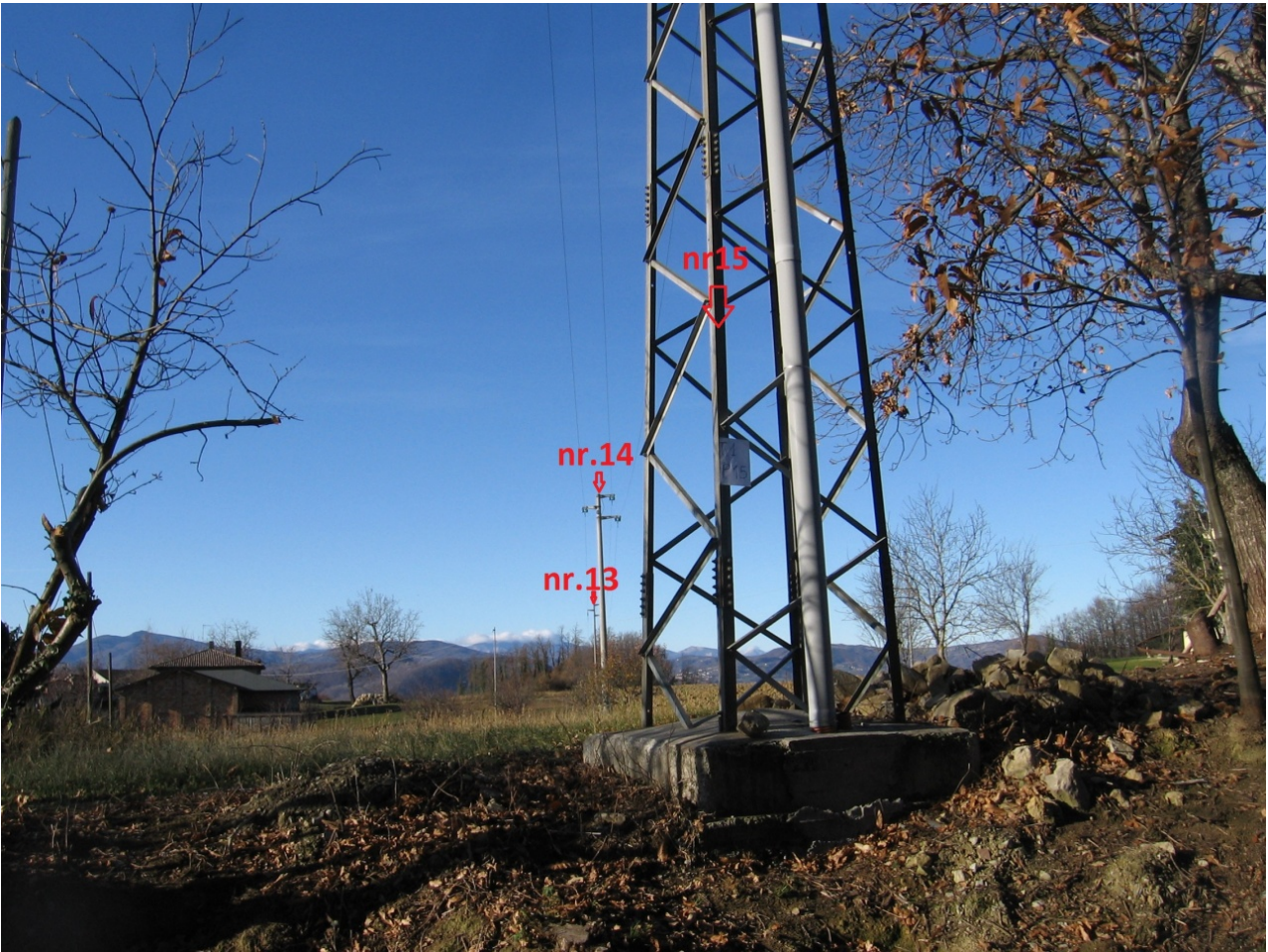
Vista attuale del traliccio nr.15 – Tronco 1, da sostituire con palo in acciaio.
