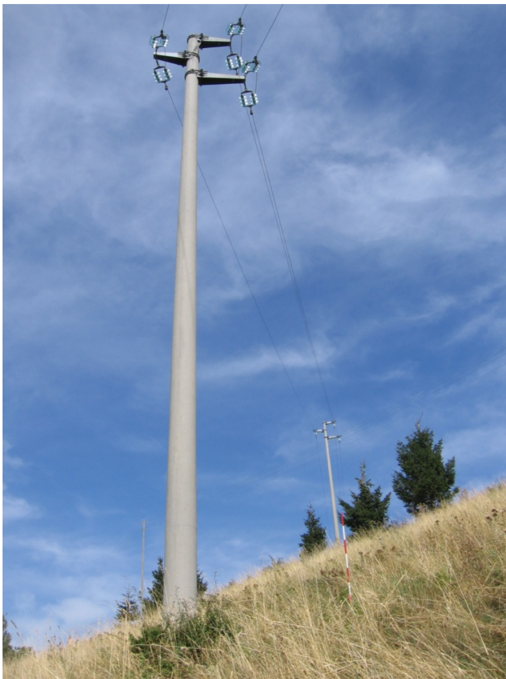
Vista attuale del palo nr.18 – Tronco 1, da sostituire con palo in acciaio.
