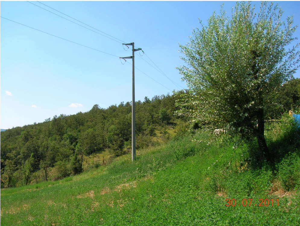
Vista attuale del palo nr.36 - Tronco 2, da sostituire con palo in acciaio.
