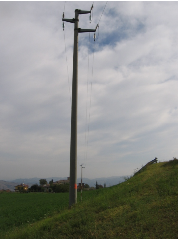
Viste attuali del palo nr.31– Tronco 1, da sostituire con palo in acciaio.
