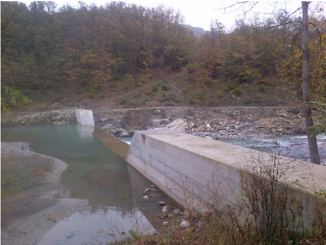
Figura 13 – vista dell’area d’intervento dalla sponda destra (monte)
