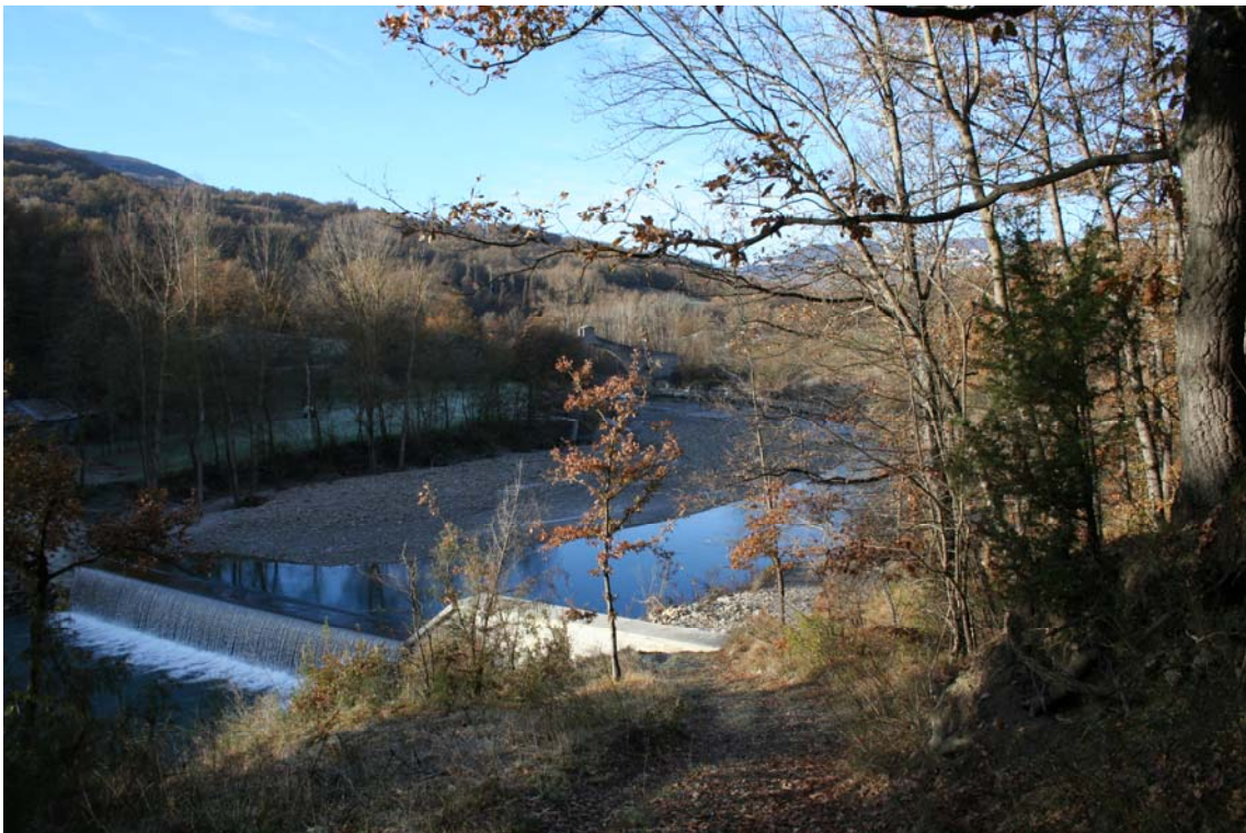
Figura 11 – vista dell'area d'intervento da nord
