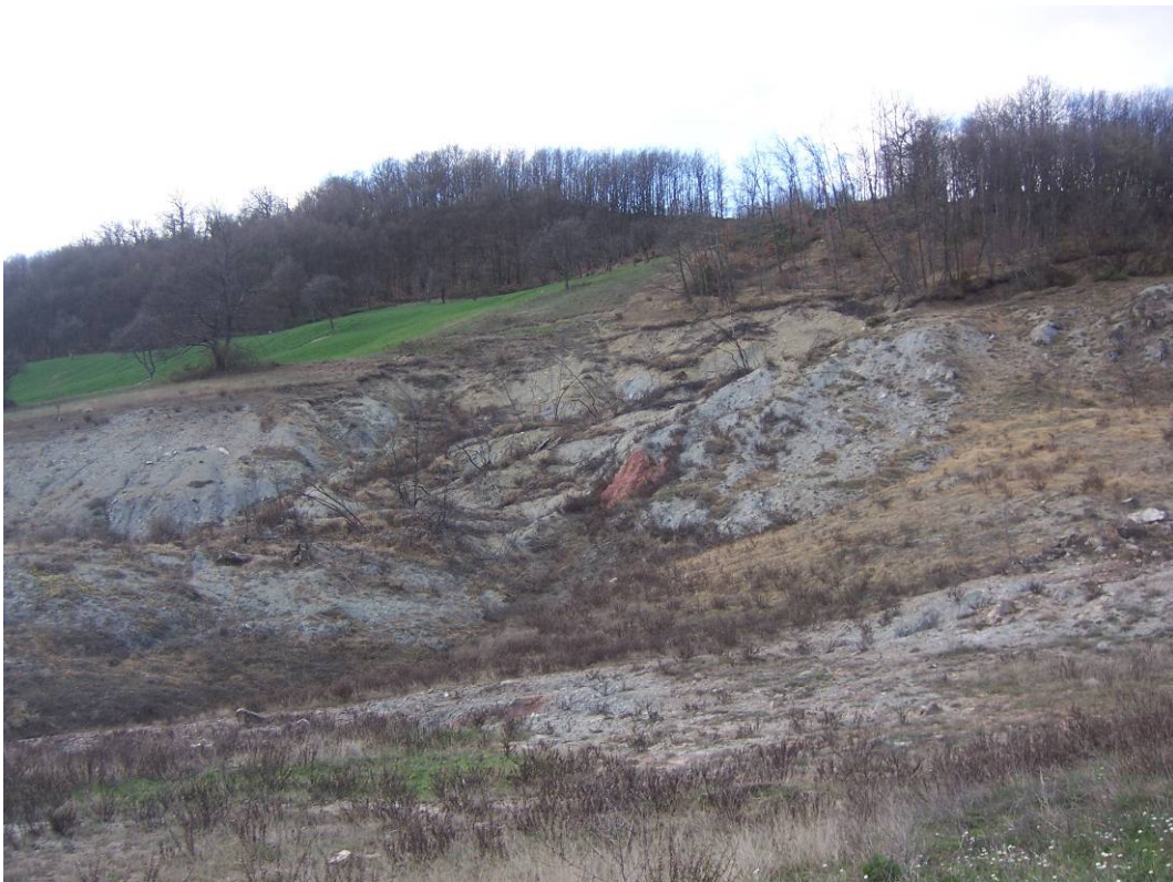
Fotografia 2: colate di terra che hanno interessato l'area di cava e che mostrano recenti segni di attività nelle aree sorgente rappresentati da decortizzazioni del manto erboso e superficiali crepacciamenti.
