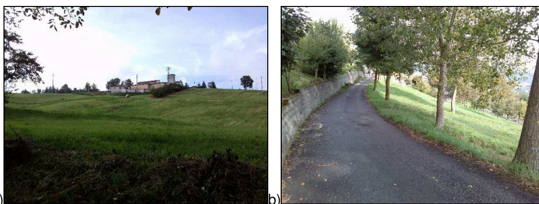
Figura 8 – a) Panoramica dell'area sorgente della frana quiescente cartografata nel PTCP a monte dell'area di studio; b) pendio intersecante Via Camatta, nel tratto in cui interseca la frana quiescente di cui al punto a).
