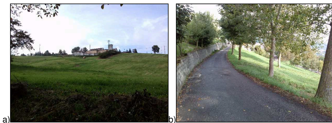
Figura 8 – a) Panoramica dell'area sorgente della frana quiescente cartografata nel PTCP a monte dell'area di studio; b) pendio intersecante Via Camatta, nel tratto in cui interseca la frana quiescente di cui al punto a).
