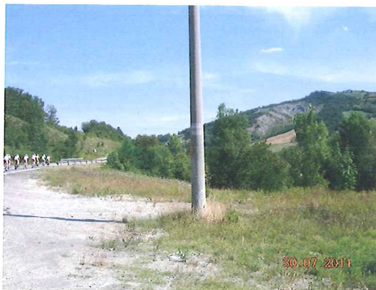
palo 5/3 visto dalla strada di fondovalle del F. Panaro
