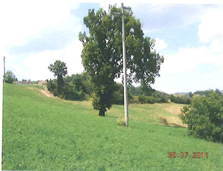
Palo 9/2 visto da SE; poco oltre la quercia, non visibili in foto, i pozzetti di drenaggio della frana q.
