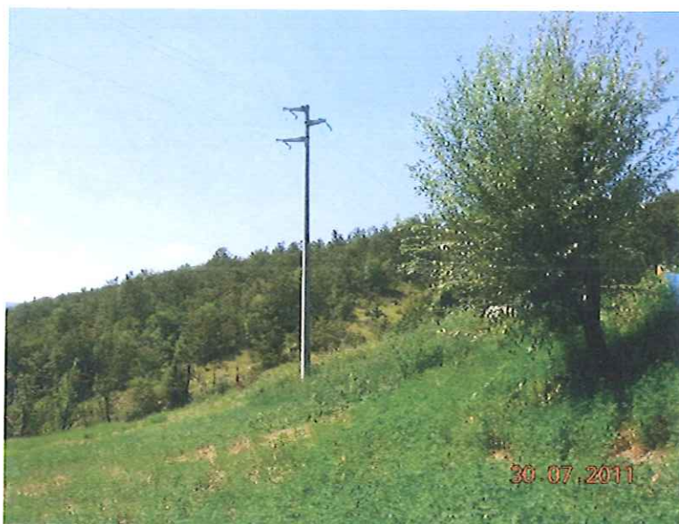
palo 36/2 visto da N, ovvero dal rilevato afferente alla stalla
