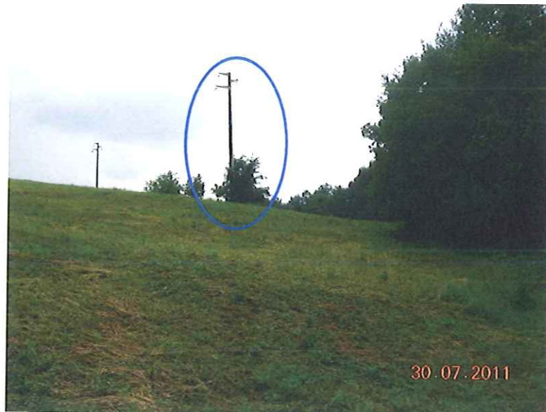
visuale del palo 12/1 dalla strada asfaltata
