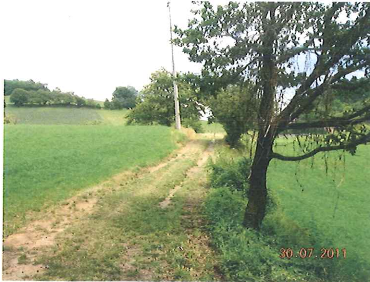
Palo 28/1 visto da W (l'apparente inclinazione del palo è dovuta al punto di scatto)
