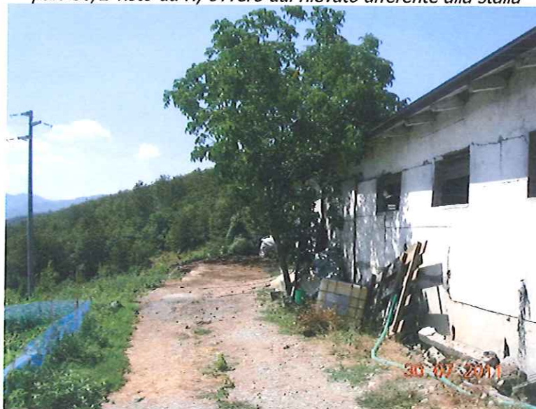
palo 36/2 visto dalla stalla con evidenti lesioni sub-orizzontali
