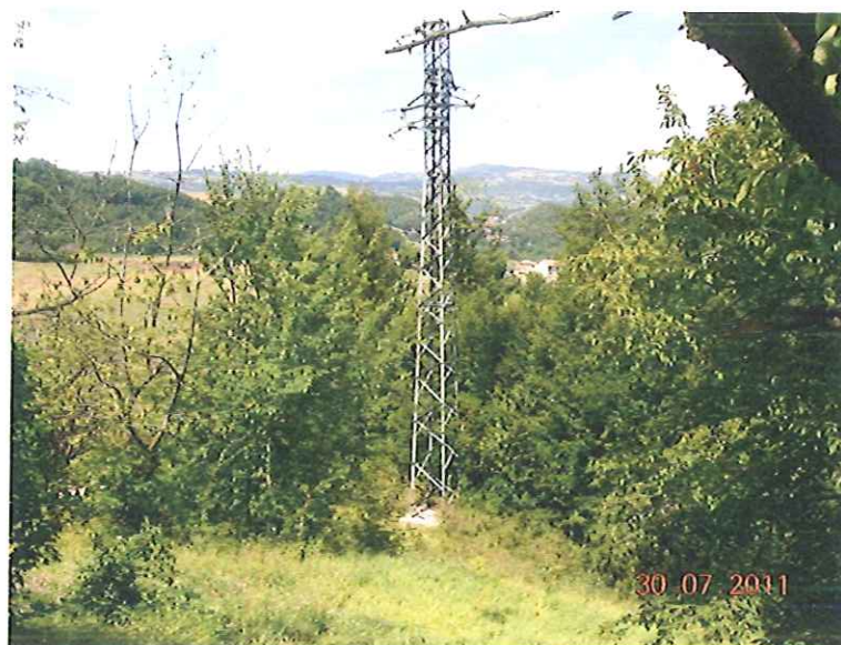
Posizione del palo 10/2 vista da monte
