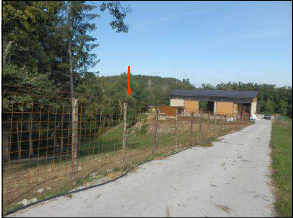
FOTO 1 VISTA DELLA ZONA D'INTERVENTO IN DIREZIONE NORD-OVEST
