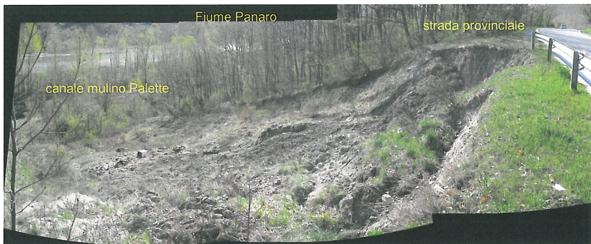
Foto 2: zona di distacco (nicchia) e scorrimento della frana
