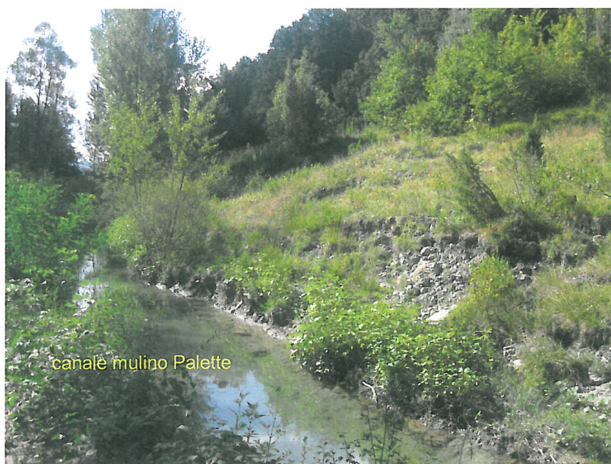
Foto 3: zona d'accumulo (piede) della frana
