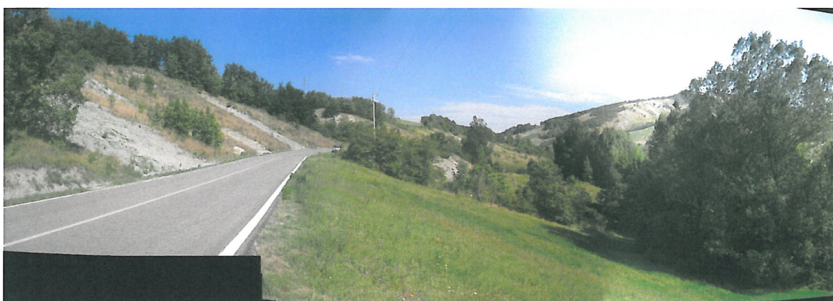
Foto 4: vista da strada provinciale verso Nord
