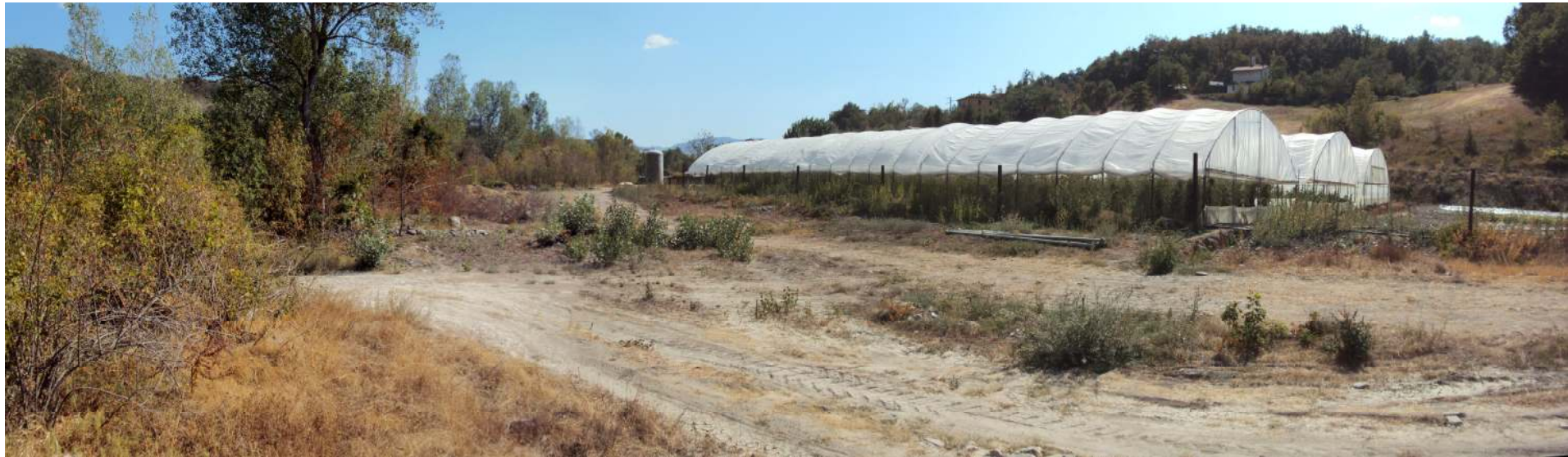
Figura 14: ripresa fotografica zona di imposta del dissabbiatore nello stato di fatto.
