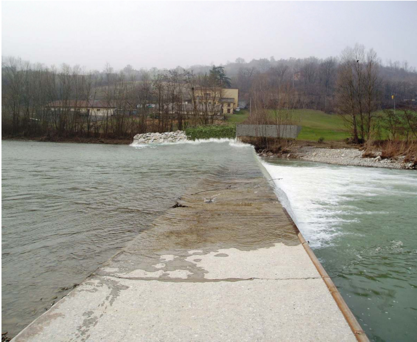
Figura 12: rendering della zona di presa ad opera realizzata
