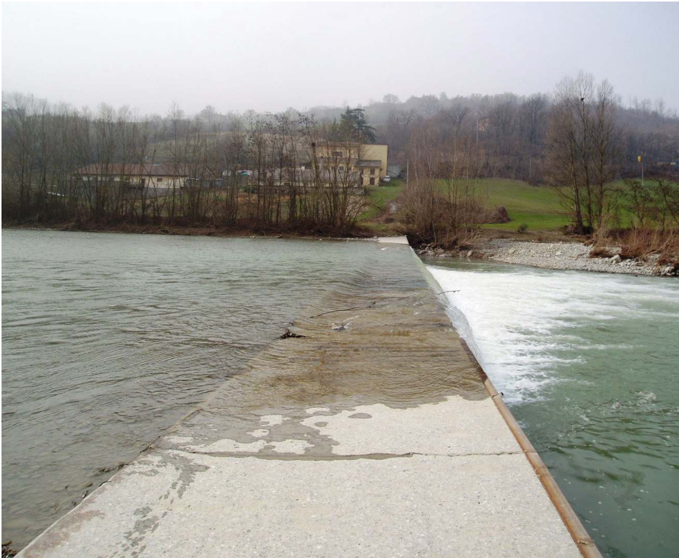
Figura 11: ripresa fotografica dalla sponda destra idraulica della zona di presa
