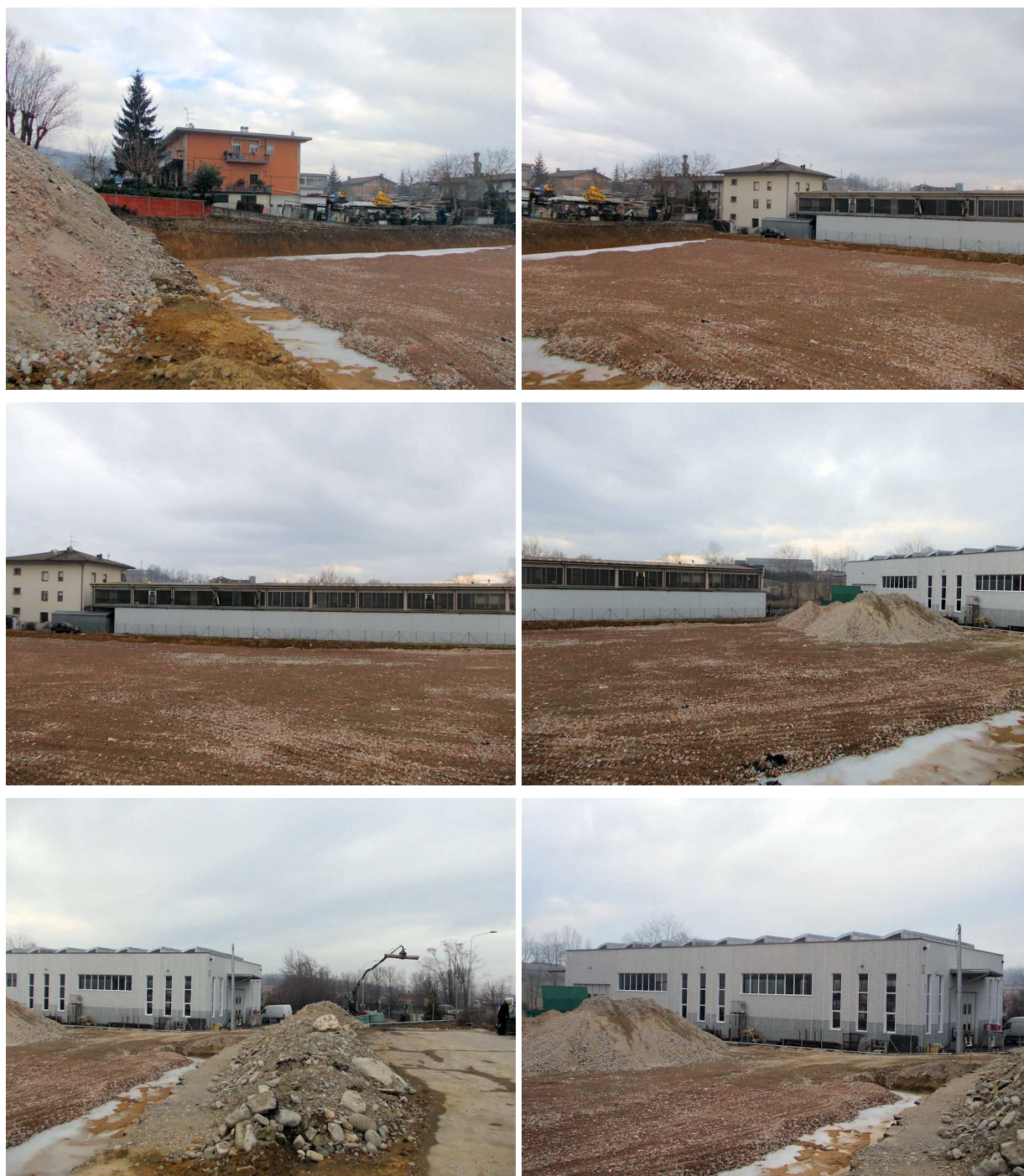
Figura 3-2 – Documentazione fotografica dello stato attuale
