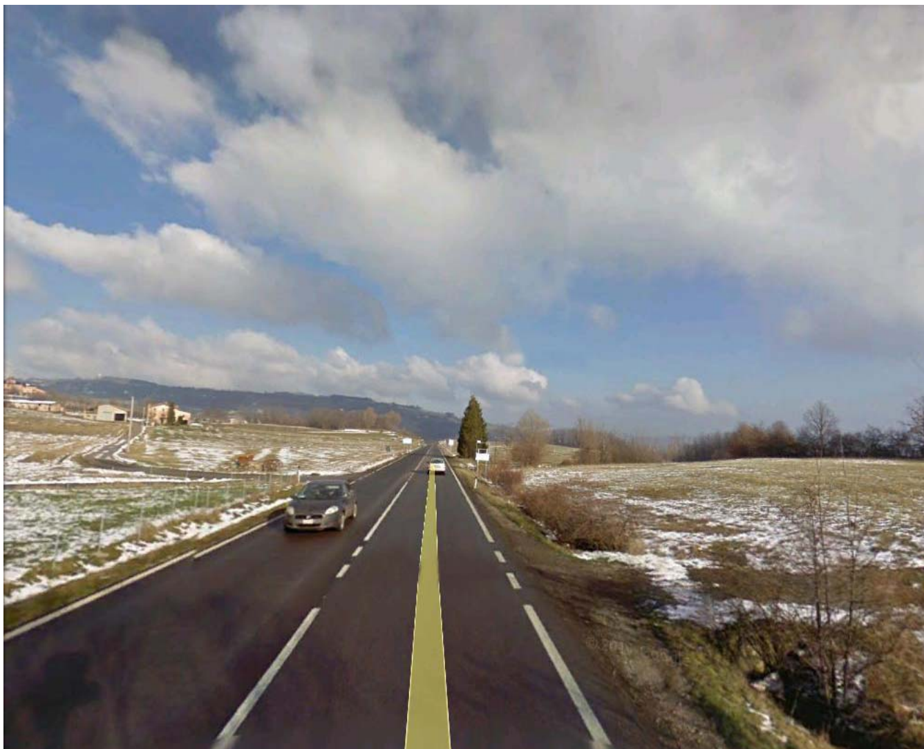
Fig. 4 – S.S.12 Via Nuova Estense in direzione Nord
