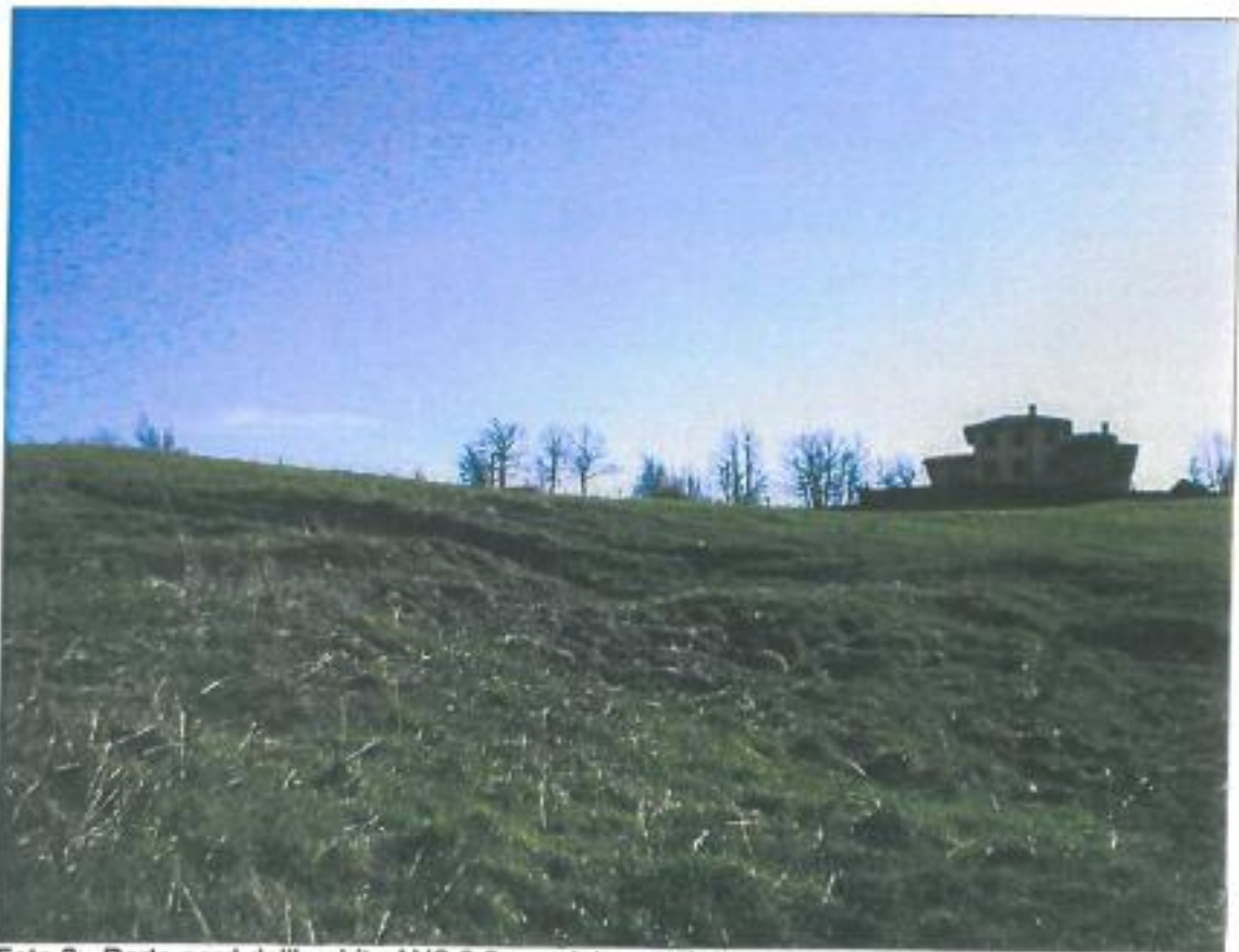
Foto 2 - Parte nord dell'ambito ANS 3.2, parzialmente interessato da fenomeni di dissesto
