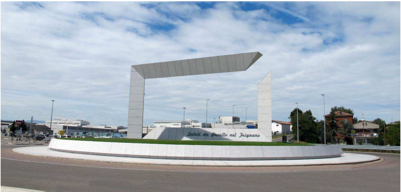
Img. 2.2 - Rotatoria stradale tra via Giardini e via Bottegone - realizzata
