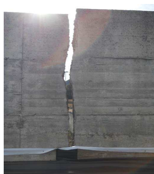
Img. 2.4 e Img. 2.5 - Cedimento di via Bottegone – vista d'insieme e dettaglio
