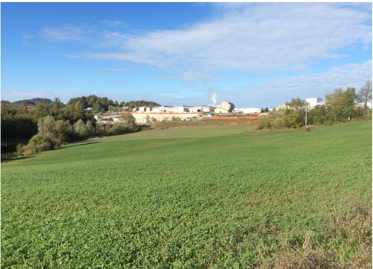
Foto 2 – Vista d'insieme dello stabilimento lato via Bottegone
