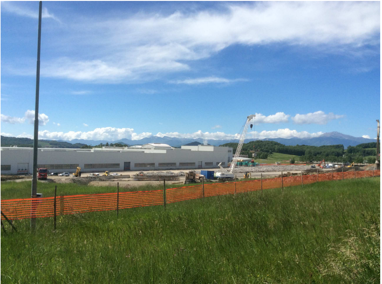
Foto 3 – Vista da ovest
