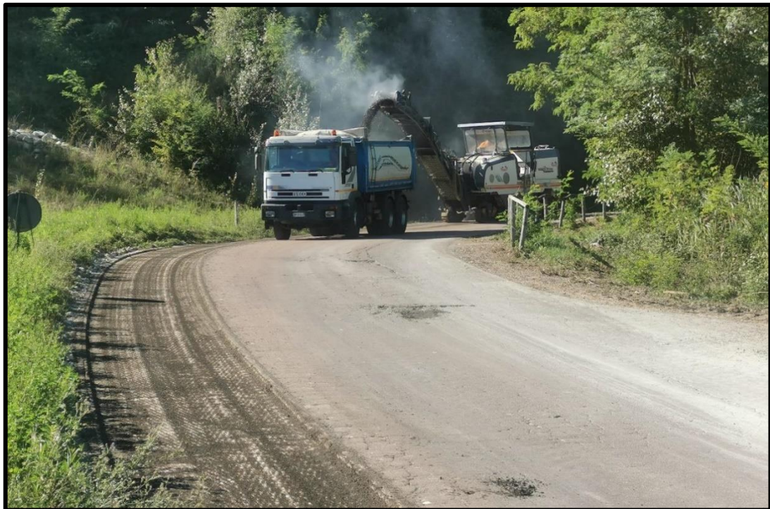
Foto 8 – Lavori di manutenzione sulla viabilità di accesso, asfaltatura in questo caso (Settembre – 2022).
