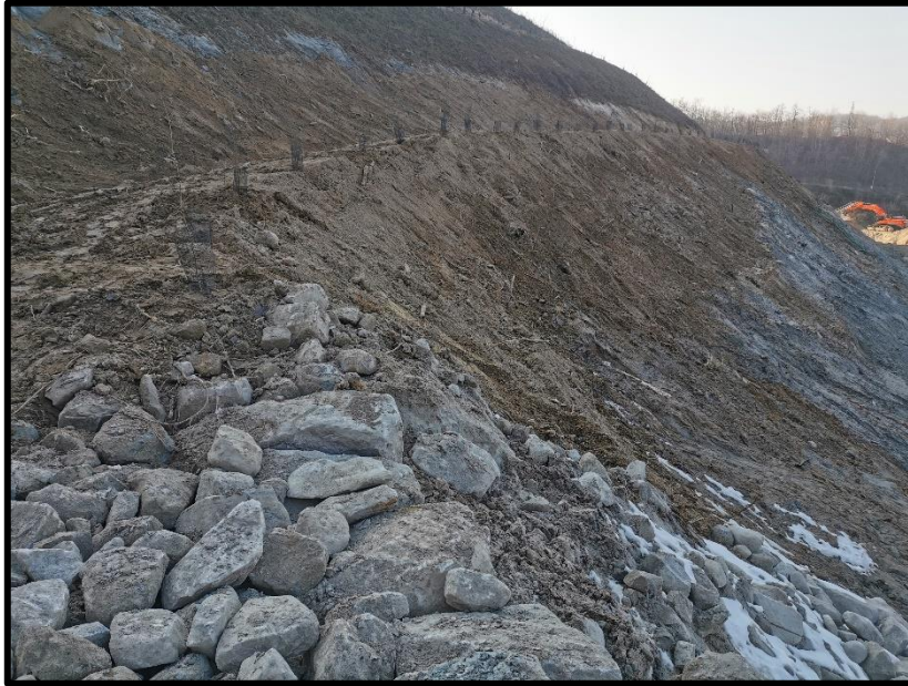
Foto 7 – Particolare di una scarpata a gradoni. Si possono notare la scogliera per la regimazione delle acque meteoriche e gli alberi messi a dimora (Marzo – 2022).
