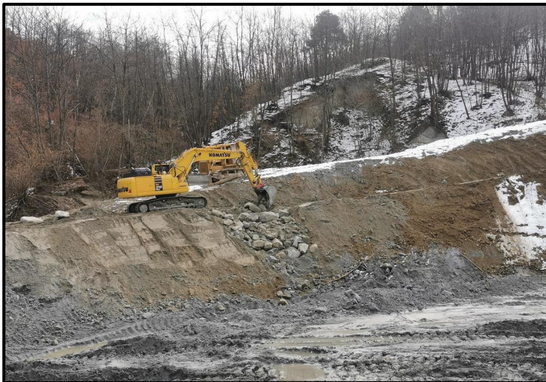
Foto 5 – Realizzazione di una scogliera per la regimazione delle acque (Marzo – 2022).
