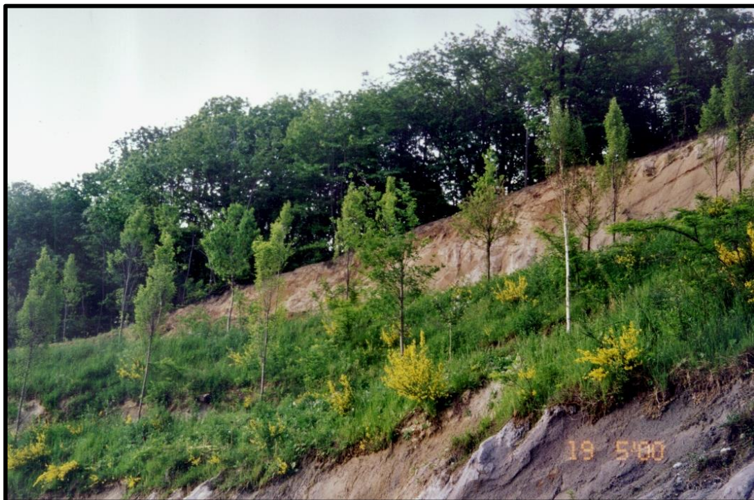
Foto 9 – Esempio di sistemazione completata: veduta della parete ovest a gradoni, sistemazione svolta diversi anni fa.
