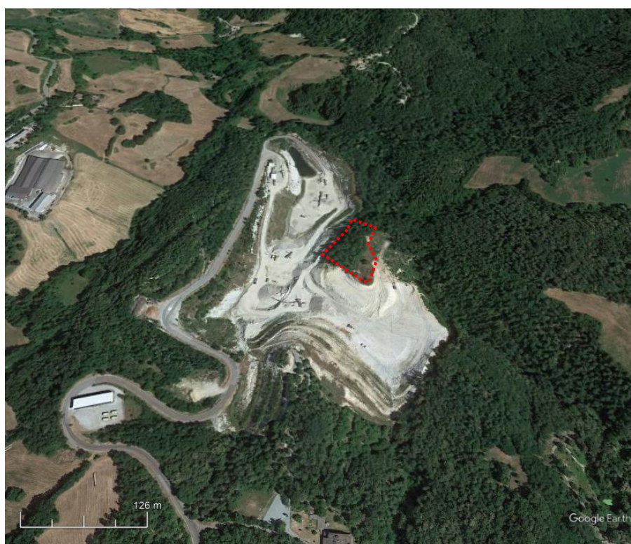
Fig. 39 - Area boscata interessata dagli scavi.
